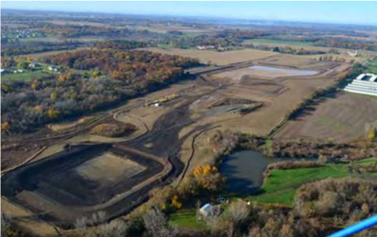
11— WL Dredging project
