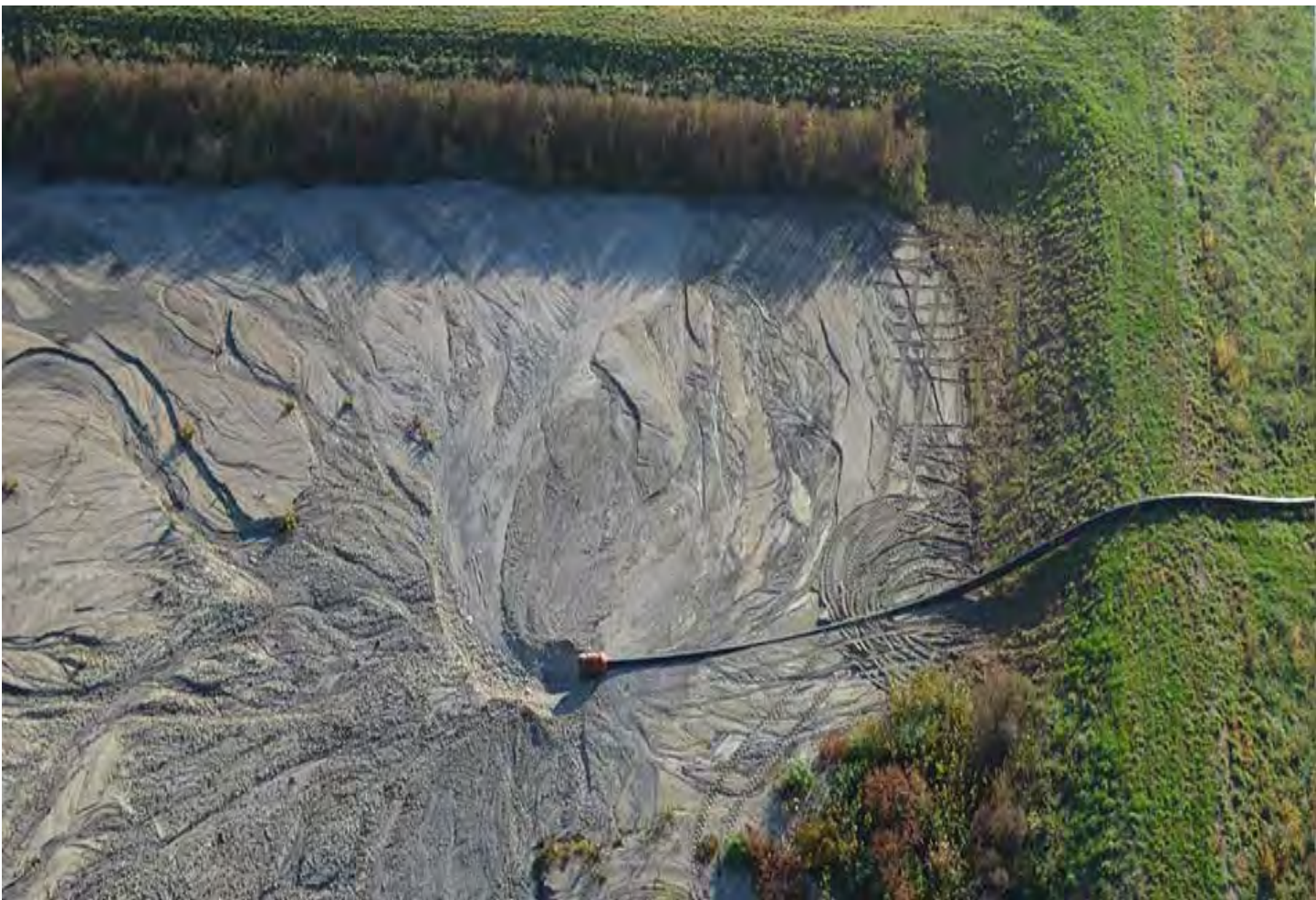
35— WL Dredging project
